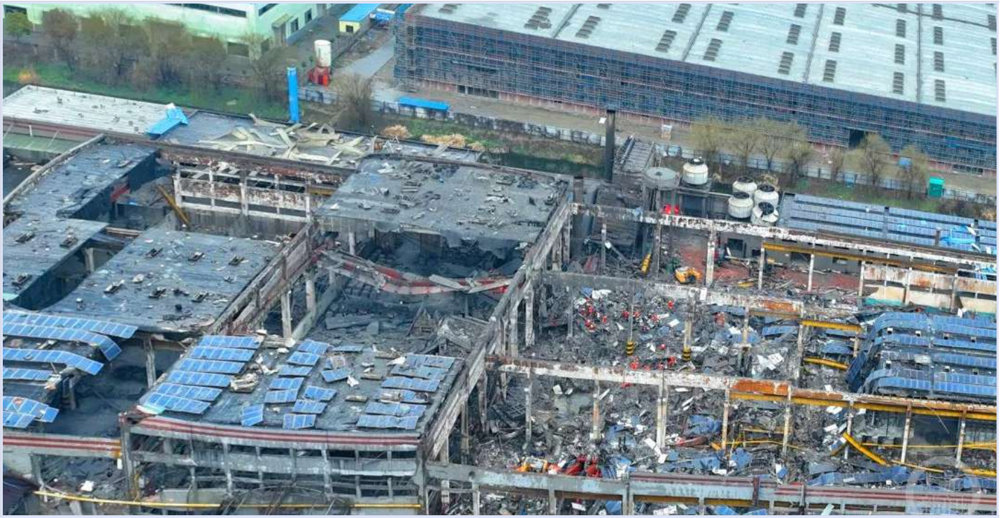
航拍事故现场
